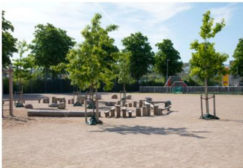
Figur 9. Exempel på svagt skålade ytor där vatten kan bli stående vid större regn och sedan långsamt tömmas till ledningsnätet via bräddbrunn. Bild från Malmö stad
