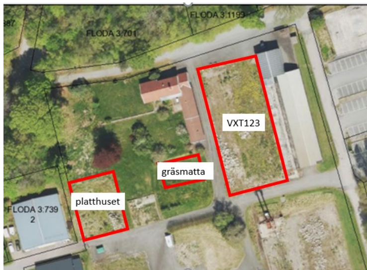
Figur 20 Tre områden i norra delen som benämns i markföroreningsutredningen
