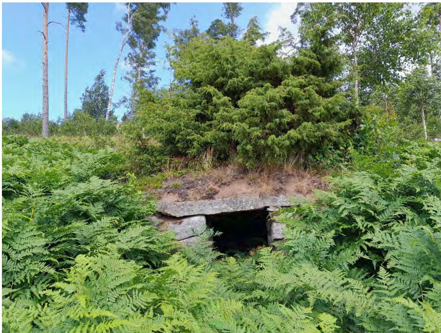
Figur 13. I området finns rester från tidigare bosättning i form av husgrunder och jordkällare.
