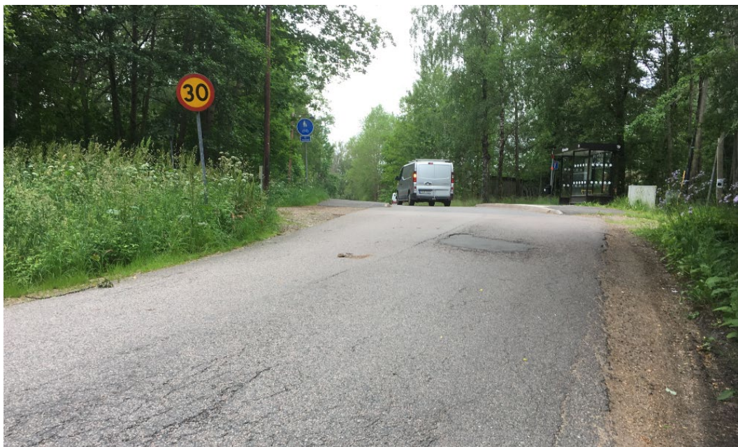
Figur 23. Gamla Sågvägen strax efter korsningen med Brännabbenvägen. I bilden syns vagt det korsande gång- och cykelstråket. Vänster i bild syns gång- och cykelbanan utmed Gamla Sågvägen. Höger i bild syns busshållplatsen. Foto ÅF 190627.
