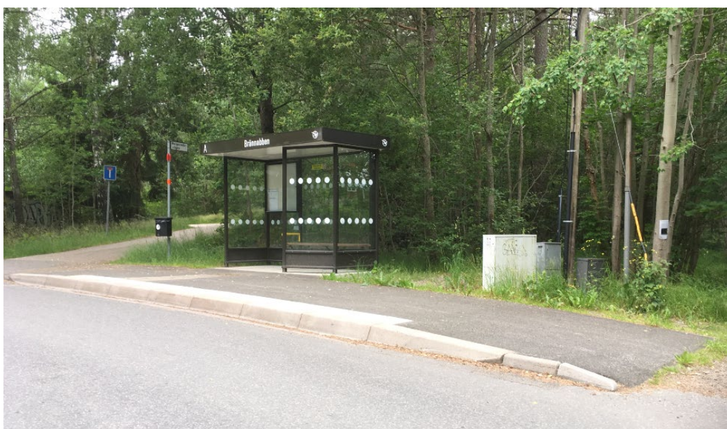
Figur 24. Busshållplatsen Tollerød Brännabben är tillgänglighetsanpassad. Foto ÅF 190627.
