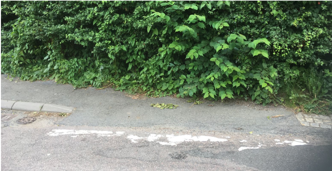
Figur 13. Buskage vid övergångställes anslutning till södra gångbanan vid Tollereds ströms väg. Foto ÅF 190627.
