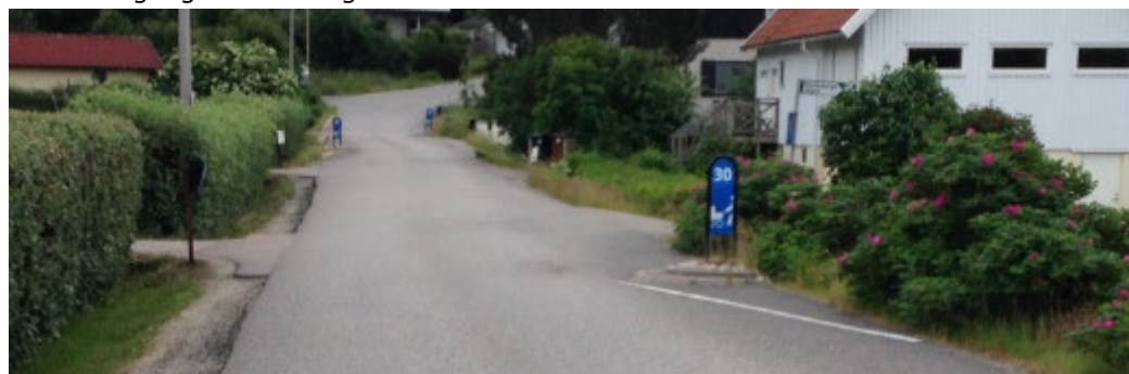
Figur 4. Sidorefuger som hastighetsdämpande åtgärd på Snipåsvägen. Foto ÅF 190627.
