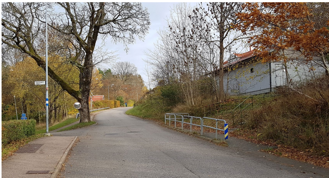
Figur 17. Snipåsvägen. Gång- och cykelanslutning med dålig standard till höger i bild. Lutande gångbana samt spegel på träd till vänster. Foto ÅF 191021.
